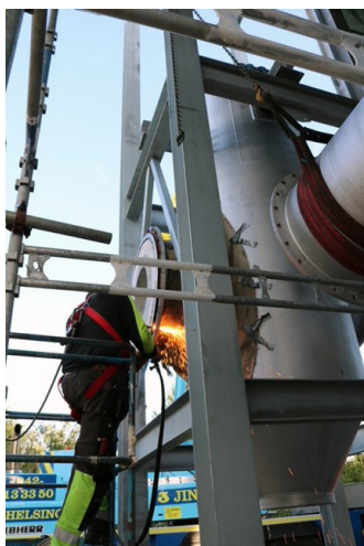
Installationsarbete i Höganäs
