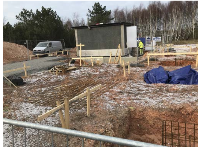
Pågående markarbeten i Höganäs.
