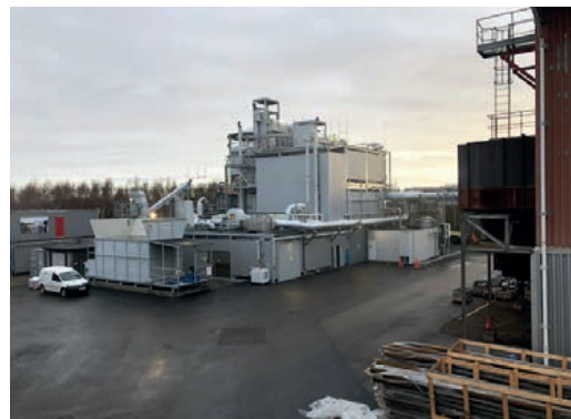
Anläggningen i Höganäs, februari 2019.
